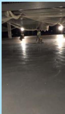
Chape ANTI-USURE Quartz est un durcisseur de surface haute performance composé de granulats minéraux et synthétiques de grande dureté et d'un liant hydraulique enrichi d'additifs réactifs.
